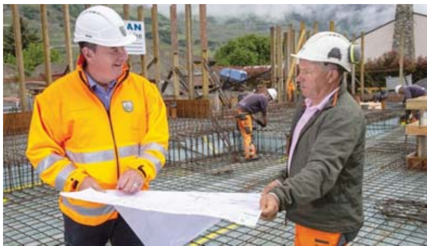
Sur ce chantier de l'entreprise Vaudan SA à Saillon, Fernando Carvalho (à droite) et Sébastien Clerc discutent des mesures de sécurité à respecter. SACHA BITTEL
